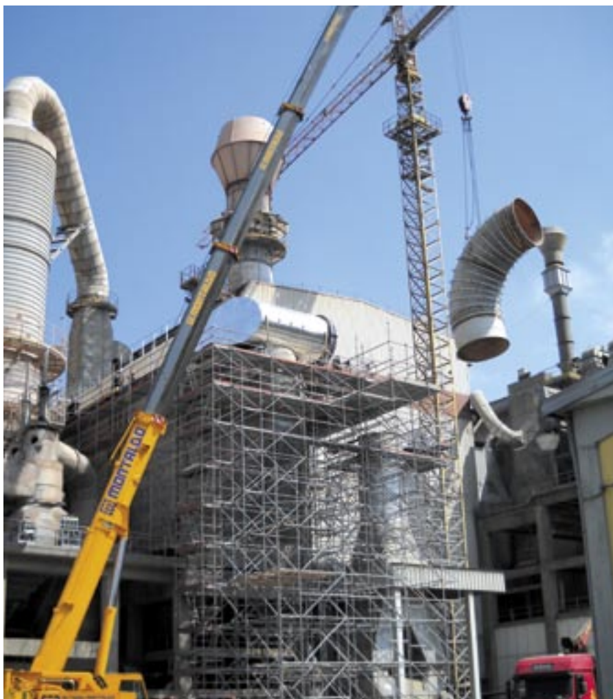
Posizionamento curva aspirazione gas filtro REDECAM
